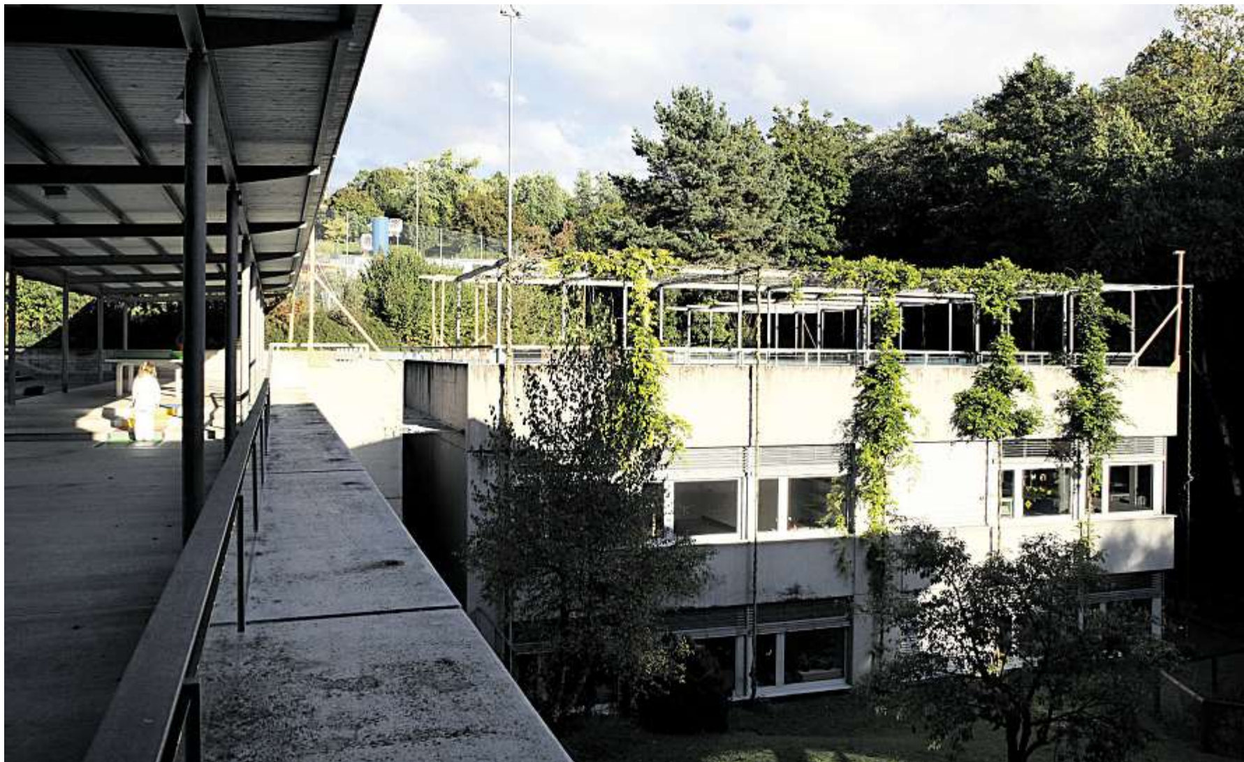
Die Platzprobleme im Schulhaus Juch sollen gelöst werden, indem das Gebäude teilweise aufgestockt wird. Bild: Sabine Rock
