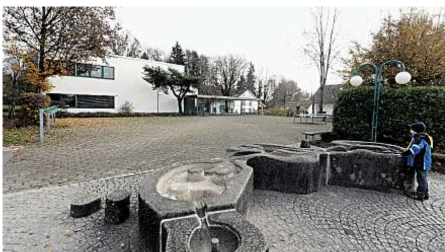
Auf dem Pausenplatz des Schulhauses Tobel 1 ist ein Neubau geplant. Bild: Reto Schneider
