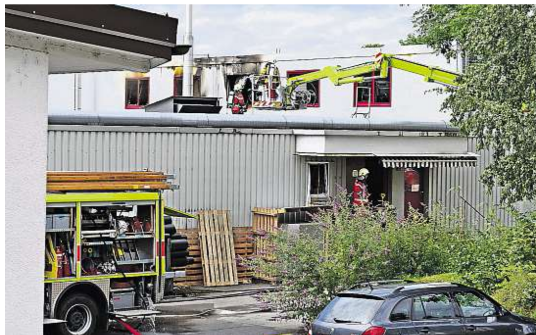
Fast eine halbe Million Franken teuer wurde der Brand an der Grossacherstrasse in Hombrechtikon.
