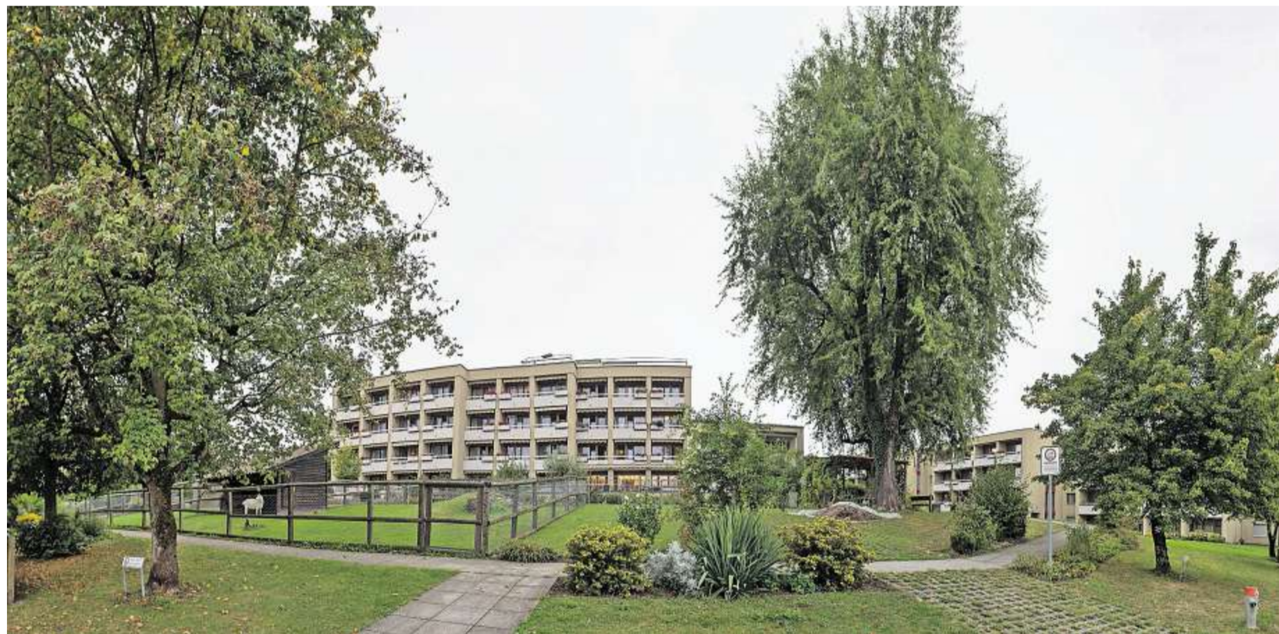
Das Alters- und Pflegeheim Breiten in Hombrechtikon hat nach über 40 Jahren ausgedient. Es soll durch ein modernes Alterszentrum ersetzt werden.
