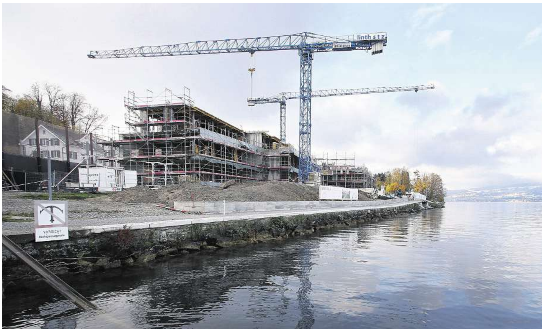
Für das Planen und Bauen am Zürichseeufer sollen bald neue Bestimmungen gelten, die je nach örtlichen Gegebenheiten von den Gemeinden ausgearbeitet werden.
