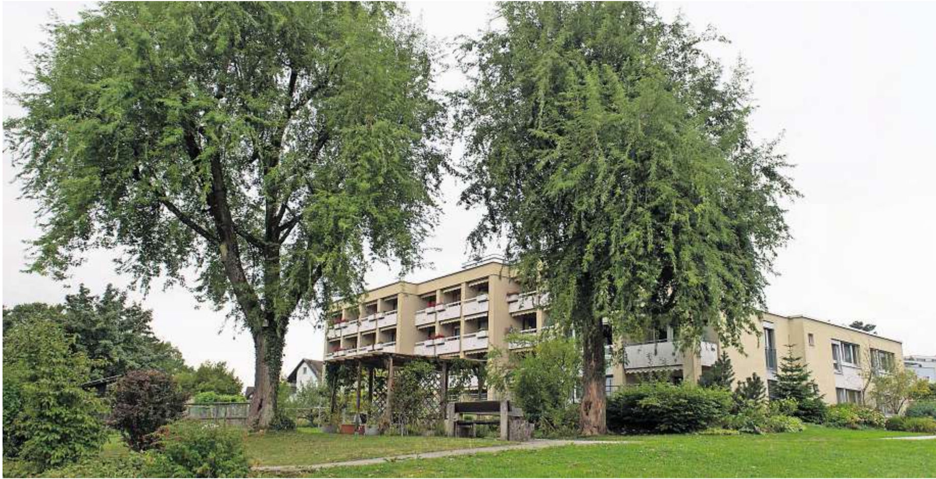
Das Alterszentrum Breiten soll neu gebaut und mit weiteren Alterswohnungen ergänzt werden. Ein neuer Pflegezweig genüge, sagen die Gegner der Vorlage.
