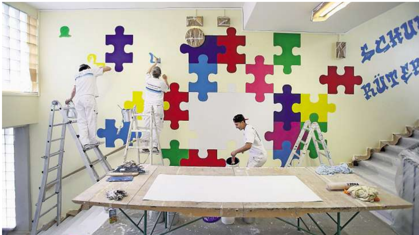
Der Eingangsbereich des Schulhauses Rüterwies A in Zollikon bekommt ein neues Gesicht. Lehrlinge der Malerfirma Schlagenhauf malen die Wände gratis bunt an. Die Schule hat diesen Preis in einem Wettbewerb gewonnen.
